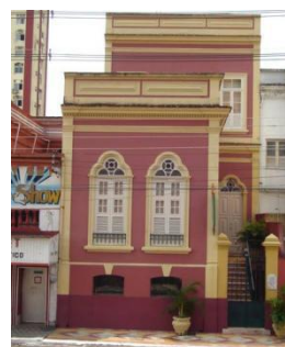
Fig. 08 e 09– Imóvel do entorno do Teatro Amazonas, antes e após a intervenção: a retirada do toldo sobre o porão revela os guarda-corpos originais das janelas do 1º. pavimento. Fotos: Acervo da Casa do Restauro e Márcia Honda N. Castro.
