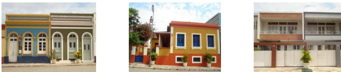
Fig. 13 a 15 - Exemplos de cromatização de fachadas no projeto do entorno do Teatro Amazonas. Fotos: Márcia Honda N. Castro.
