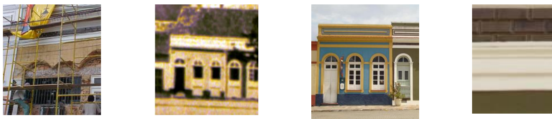
Fig. 04 – A prospecção da argamassa revelou os arcos originais das esquadrias e uma viga acrescida para dar sustentação aos novos vãos. Fonte: Acervo da Casa do Restauro. Fig. 05 e 06 - Percebe-se que o contraste original de cores do imóvel à direita, revelado pela foto antiga, foi mantido na atual intervenção. Fig. 07 – Detalhe de fachada: a faixa inferior, em massa acrílica, recebe pintura em tonalidade próxima ao revestimento cerâmico original, na faixa superior. Fontes: Fig. 04, acervo da Casa do Restauro; Fig. 05, autor desconhecido; Fig. 06 e 07, Márcia Honda N. Castro.
