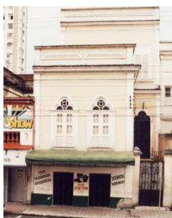
Fig. 08 e 09– Imóvel do entorno do Teatro Amazonas, antes e após a intervenção: a retirada do toldo sobre o porão revela os guarda-corpos originais das janelas do 1º. pavimento. Fotos: Acervo da Casa do Restauro e Márcia Honda N. Castro.
